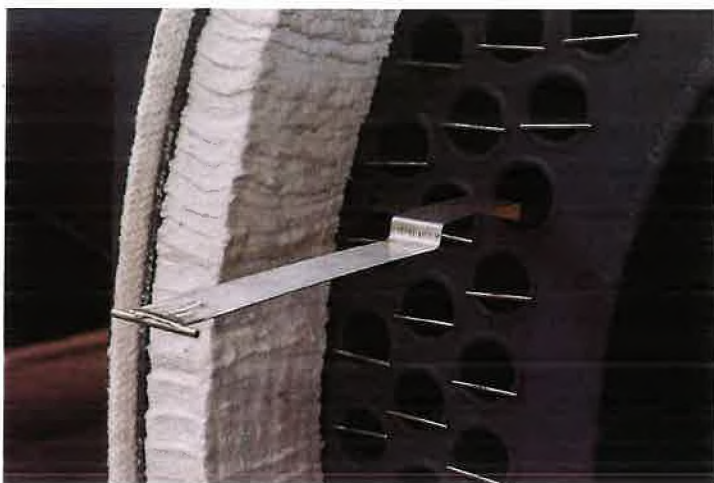
Рис.5 Пример установки турбулизаторов
