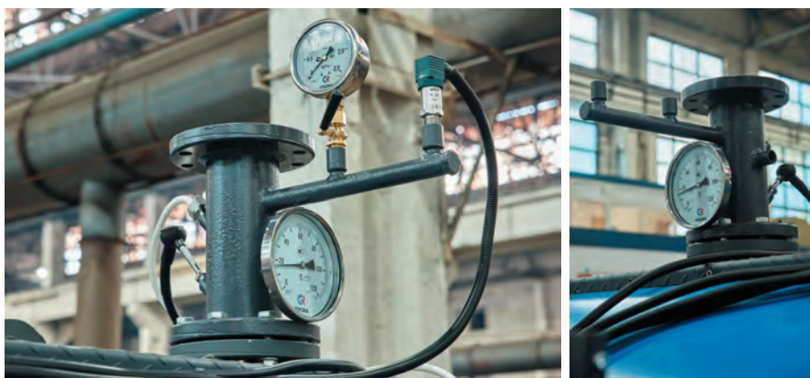
Пример установки приборов КИПиА на проставках.
